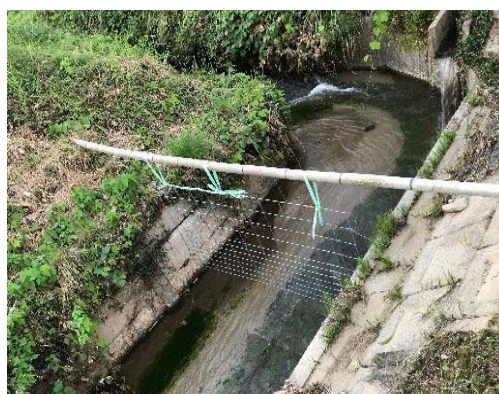
写真5 水路に設置された柵
