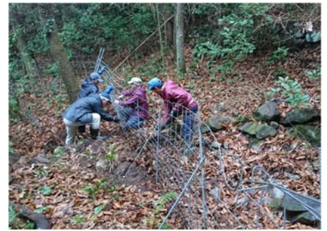
写真3 集落点検・補修の様子
