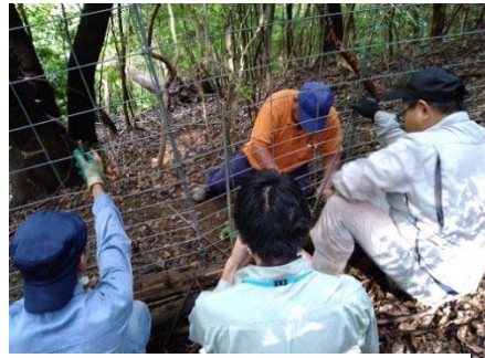
写真3 WM 柵の補修作業
