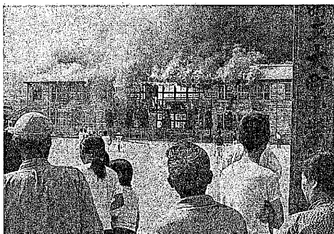
大町小学校火災 昭和49年6月
