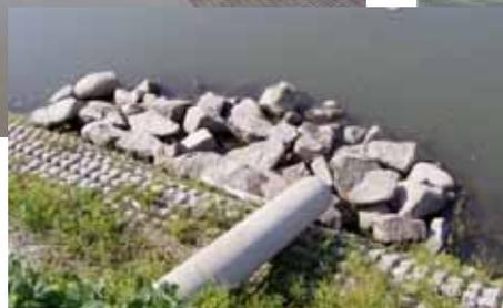
捨石は両岸50m間隔で設置しており、捨石の規模は概ね長さ3m、高さ1.5mあり、一つの石は50kg内外程度のものを設置した。
