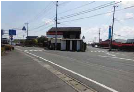
起点側より終点側を望む
