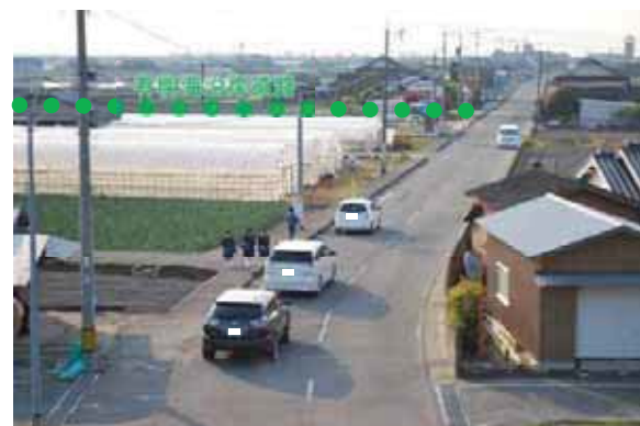
起点側より終点側を望む
