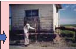
地盤沈下による抜上り
