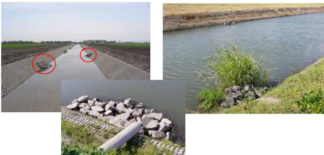
捨石は両岸50m間隔で設置しており、捨石の規模は概ね長さ3m、高さ1.5mあり、一つの石は50kg内外程度のものを設置した。
