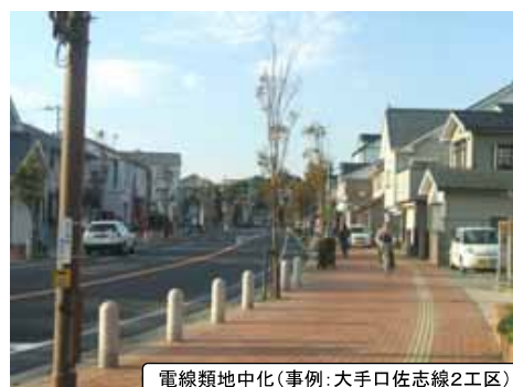
電線類地中化(事例:大手口佐志線2工区)
