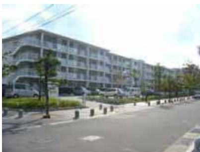
団地外周の緑化事例
