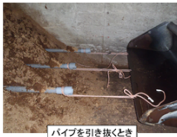
写真1 シーソー式の塩ビ製通気パイプの設置
