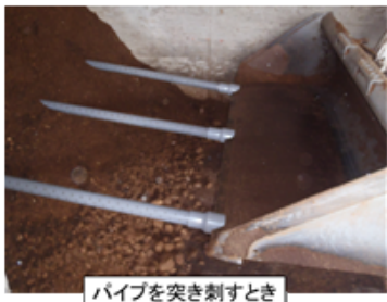
写真1 シーソー式の塩ビ製通気パイプの設置
