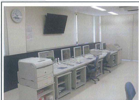
平成22年製の井手口川ダムのダムコン
