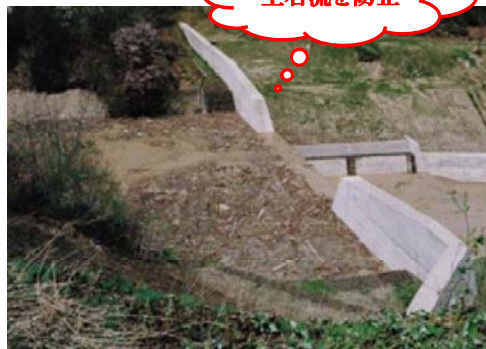
土石流発生後
