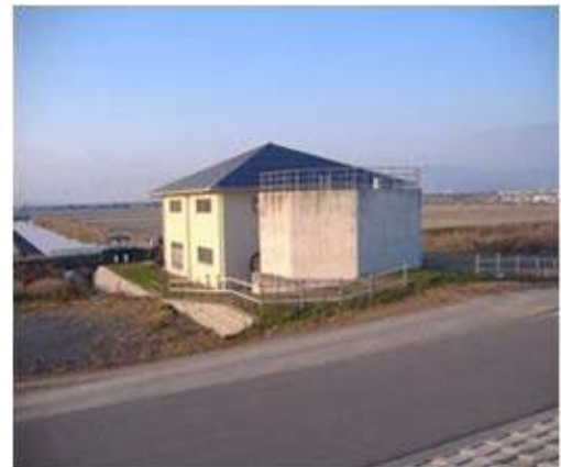
写真 2：地盤沈下による湛水被害を解消するために建設された排水機場（白石平野地区）
