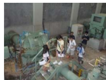
【揚水機場の見学】
