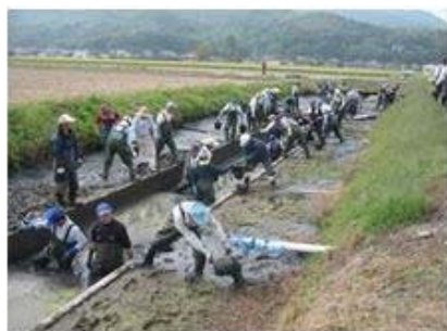
【水路の泥上げ】
