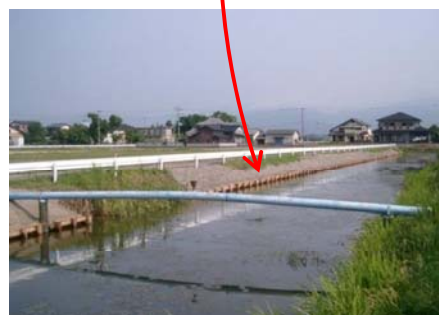
【木柵工による護岸整備】
