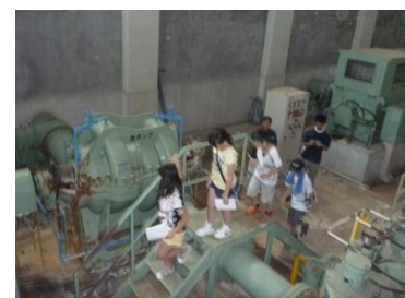
【揚水機場の見学】
