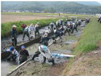
【水路の泥上げ】
