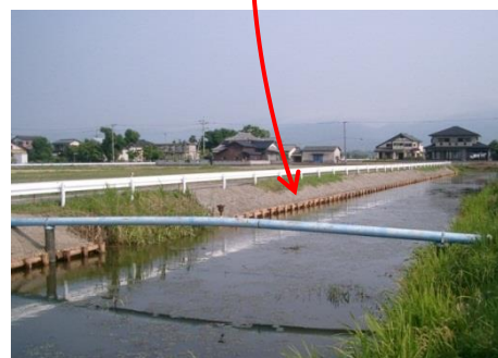
【木柵工による護岸整備】
