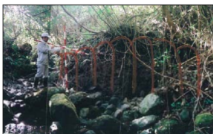
【整備前】 溪岸侵食・濁水の状況
