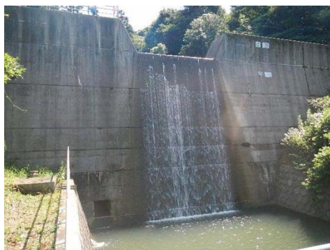
貯水型治山ダム
