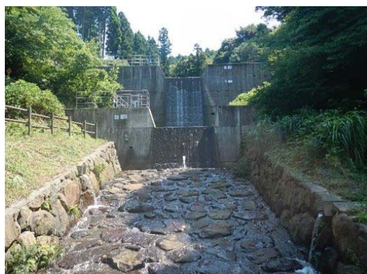
治山ダム(佐賀県で管理)
