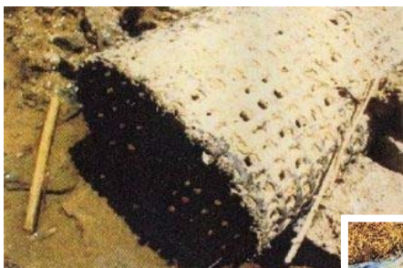
△ 変形し目詰まりした排水管
