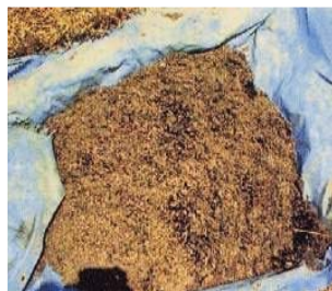
△ 腐食した疎水材（もみがら）
