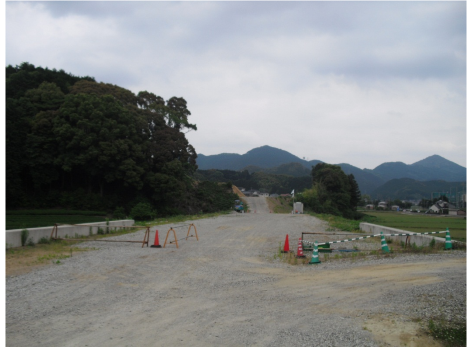
中間から終点側を望む
