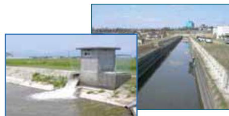
パイプラインからの分水施設
