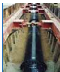
パイプライン施工状況
