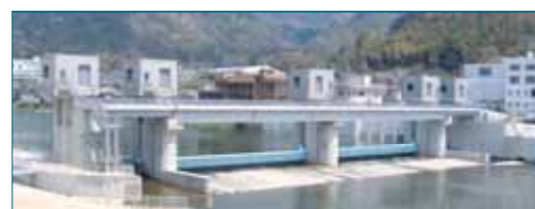
河川からの取水施設 (川上頭首工)
