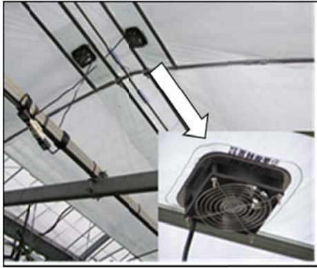
写真1 小型送風ファンの設置状況
