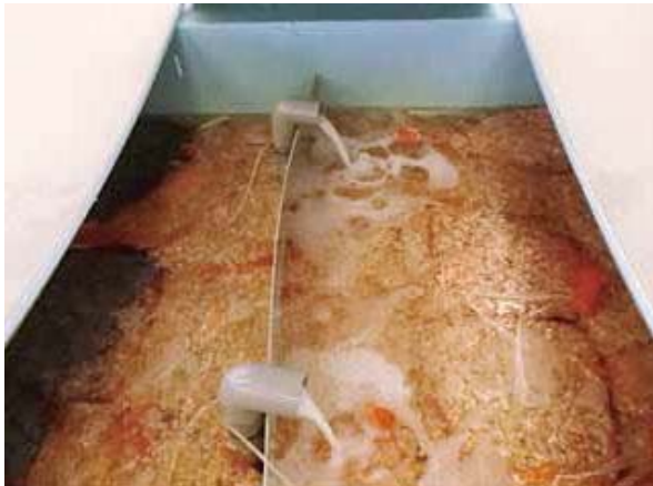
図版7-7 生物濾過槽内に設置した塩ビ板とエアリフト
