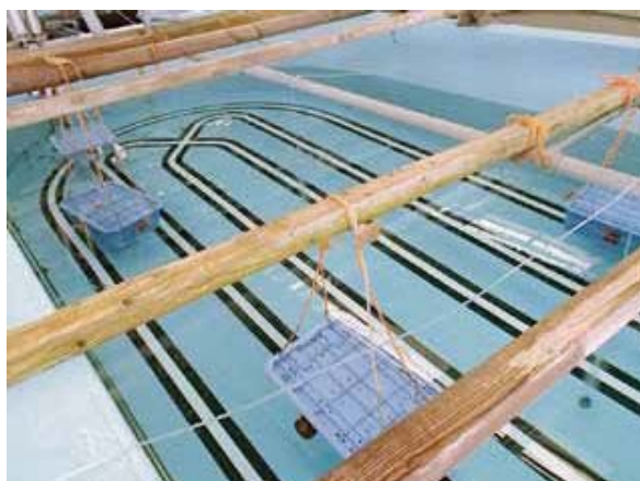
図版2-2 コンテナカゴ設置状況
