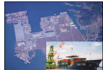
七ッ島工業団地と 国際貿易港伊万里港の様子
