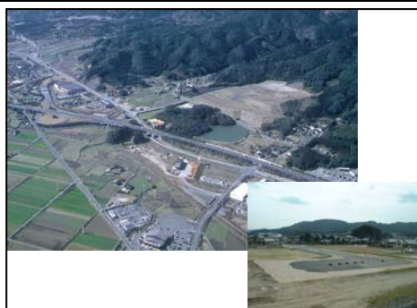
多久インターチェンジ 及び整備中のJR多久駅前広場
