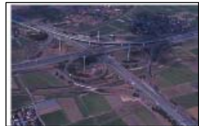
九州自動車道鳥栖ジャンクション
