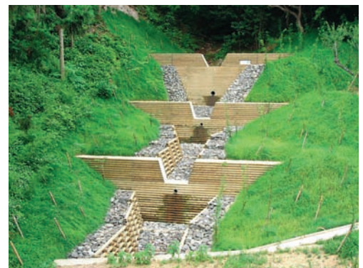
残置式小径丸太型柵で県産木材を使用し、周囲を緑化することで、自然景観と調和している。(武雄市)
