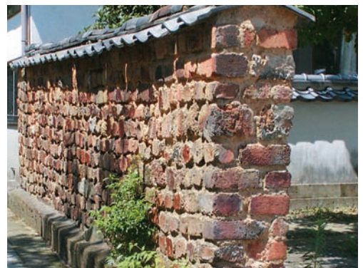
塀の素材に、地場の産業である焼き物の窯のレンガ(トンバイ)を利用し、個性ある景観を形成している。(有田町)
