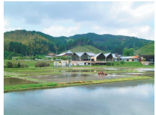
落ち着いた色の屋根、外壁を自然素材とすることにより、自然景観と調和している。(佐賀市)
