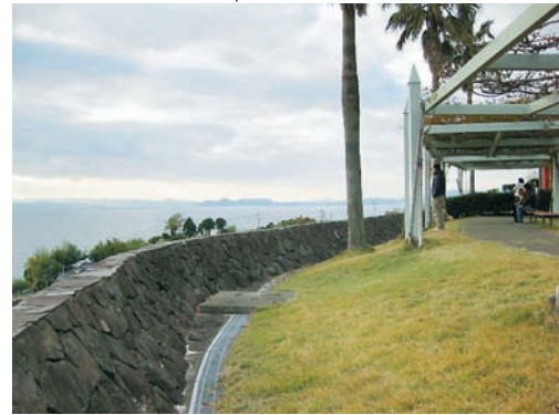
転落防護壁の位置を下げることで、防護壁の機能を確保しつつ、海が眺望しやすくし、テラスやベンチの設置により居心地を良くしている。
