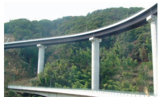
茶系の色彩とすることにより、自然景観と調和し、圧迫感が軽減されている。(福岡市)
