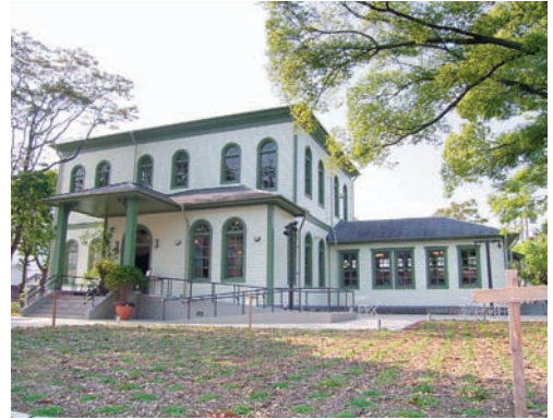
歴史的建造物を保存、活用することにより、土地固有の景観を創出している。(佐賀市)
