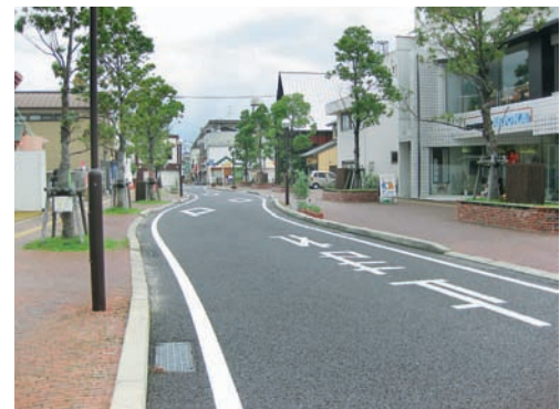
スラローム(曲線による車道の蛇行)により車の速度を抑制し、歩行者が安全に利用しやすいよう工夫されている。(佐賀市)
