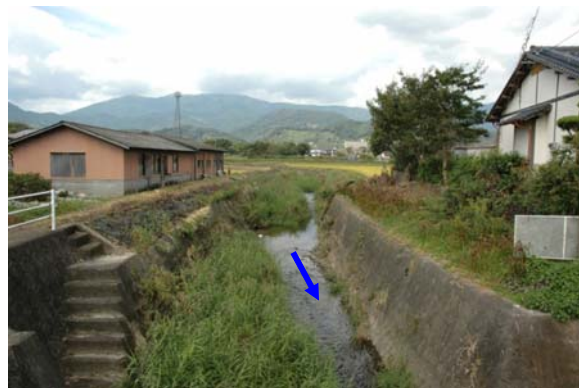
写真 5.2 砂田橋より上流を望む
