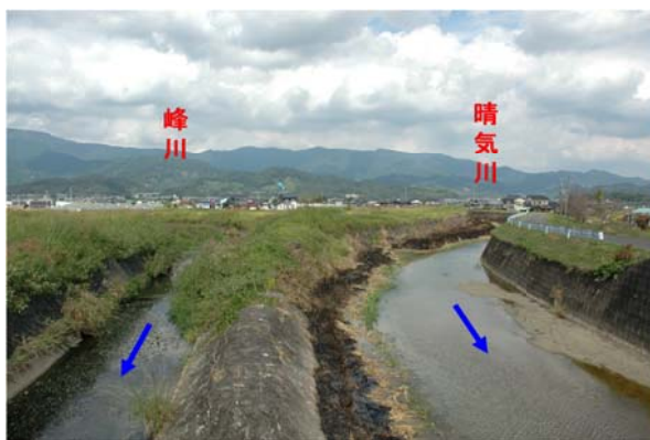
写真 5.3 坂大橋より上流を望む（峰川合流点）
