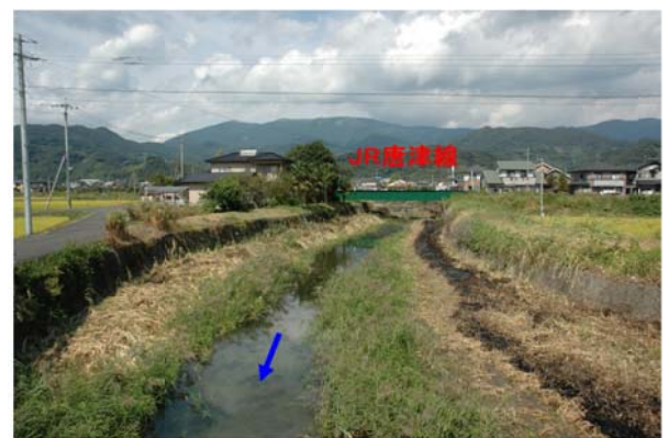
写真 5.4 黒原橋 3 号橋より上流を望む
