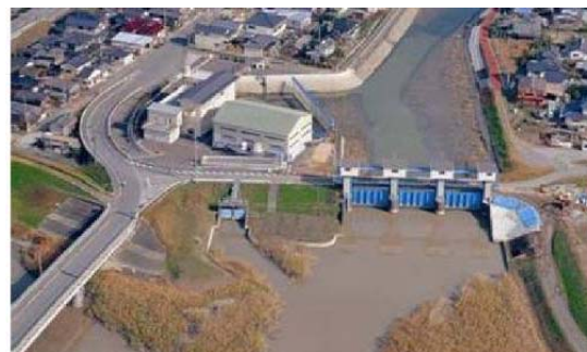
牛津江排水機場
