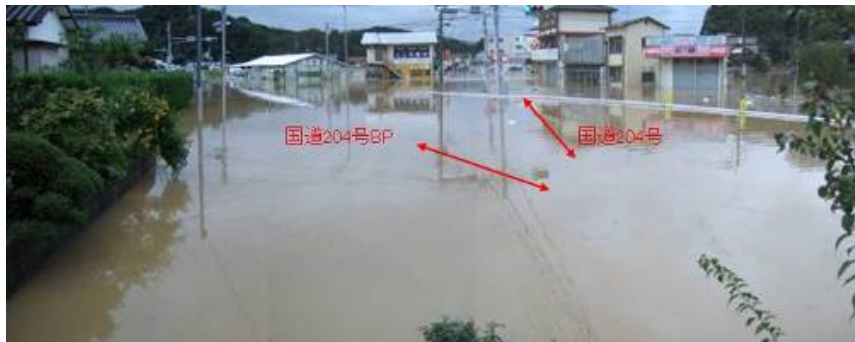
写真3 国道204号および国道204号バイパスの浸水状況
