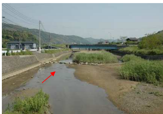
写真 2.3 汐入橋下流の河道状況
