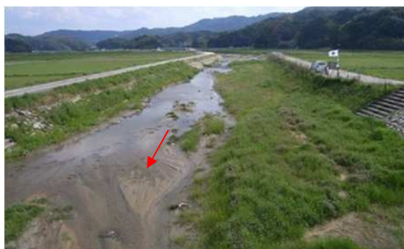
写真 5.2 水洗橋より上流を望む
