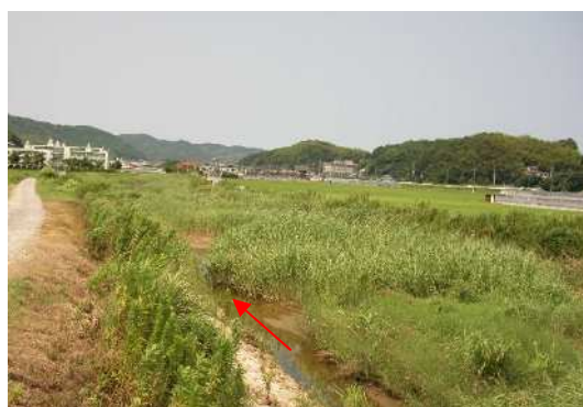
写真 2.4 中流部の河道状況
