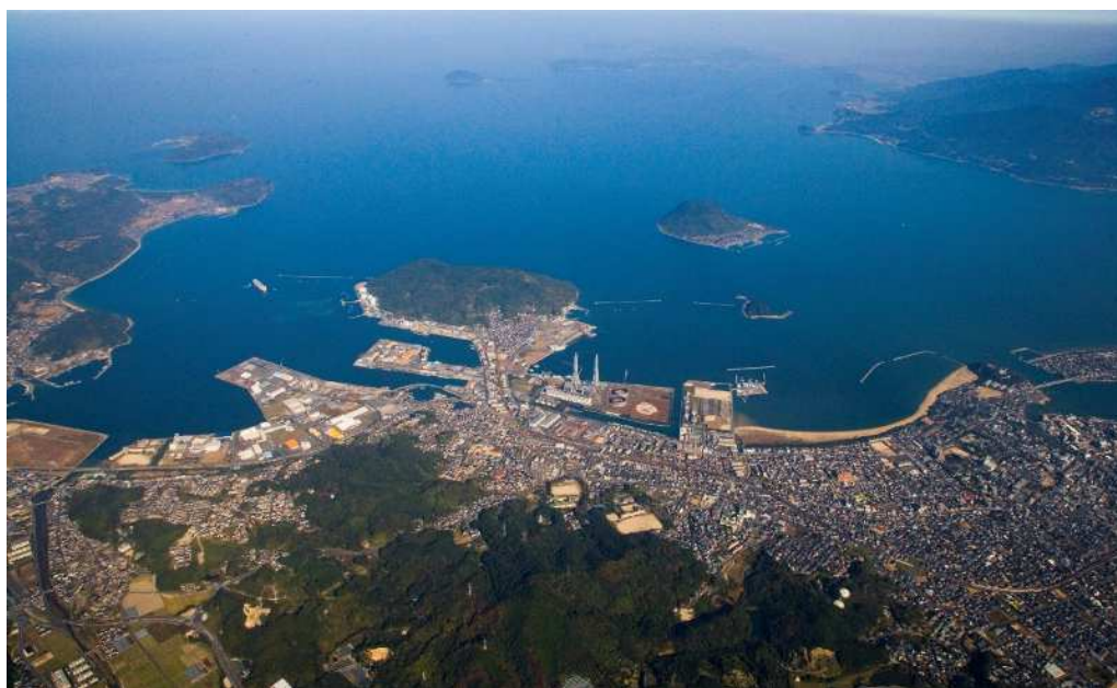
写真 1.2 唐津港の写真
