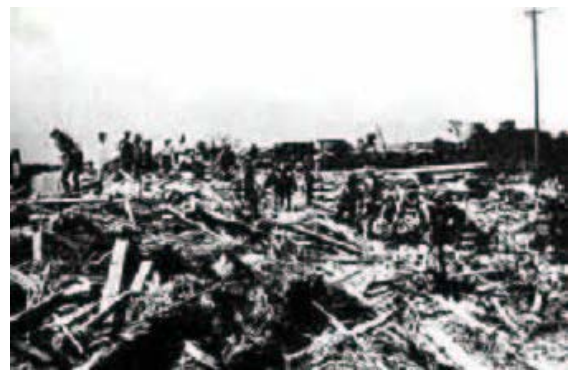
写真 1.4 高潮被害状況 (熊本県熊本市沖新)
