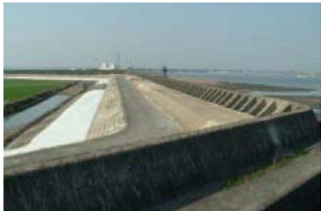
写真 1.14 川副海岸 (佐賀県佐賀市川副町)
