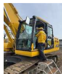
【ICT施工体験】
