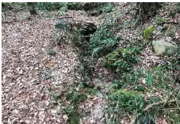
図3-1-13 石組が不明瞭になっている水路
