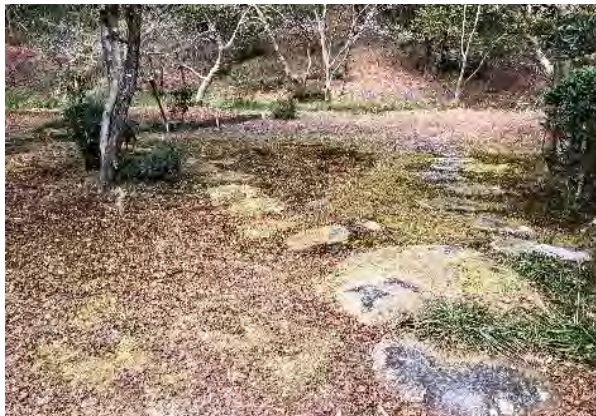
図3-1-3 苔の付着、不陸、埋没がみられる飛石
