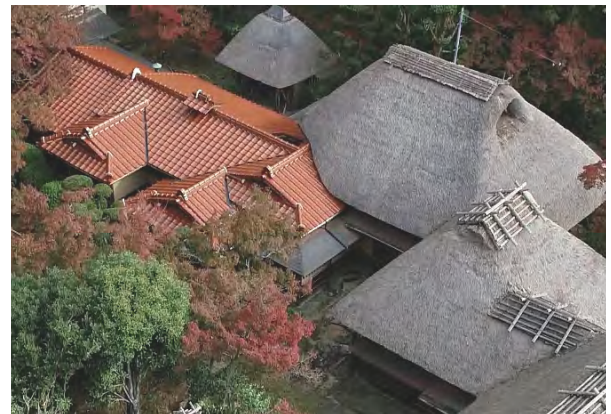
図3-1-27 屋根(雨漏りを生じやすい谷部分)
