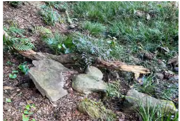
図3-1-10 倒木により破損した山灯笼
