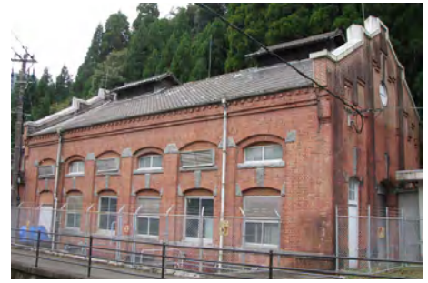
図 2-3-6 広滝第一発電所
