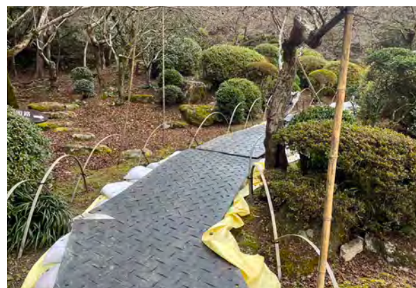
図3-2-15 指定地内園路の養生
