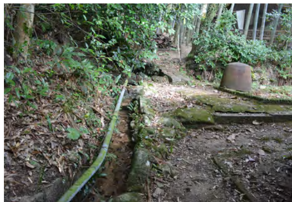
図3-1-14 落ち葉や土砂が堆積した水路
