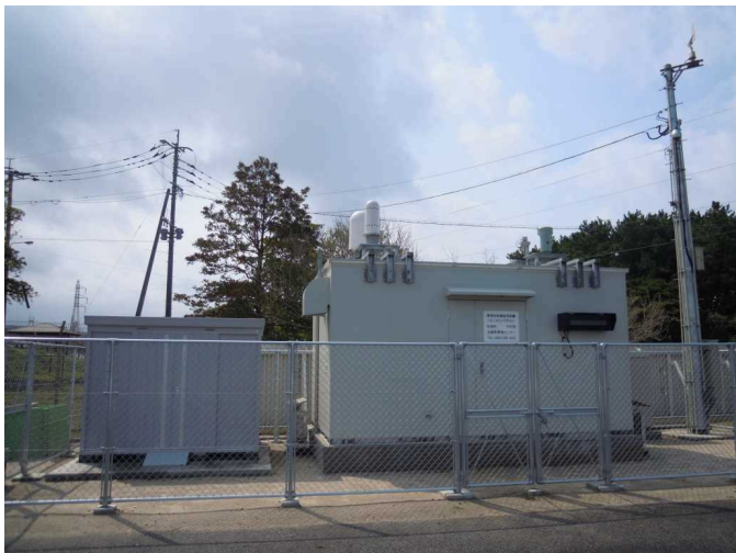
モニタリングポスト【今村局：玄海町】 空間線量率、大気浮遊じん、気象データを測定
